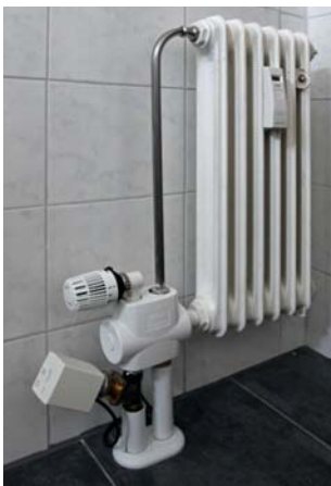
Funk-Stellventil zur Regelung der Rücklauftemperatur in Abhängigkeit der Vorlauftemperatur im Einrohrhahn. Die geforderte Temperaturspreizung zwischen Vorlauf und Rücklauf lässt sich im Regler einstellen.
