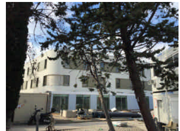
UGE CAM Marseille : > 100 chambres équipées sur PCBT, système communicant GTC, gestion point de rosée...
