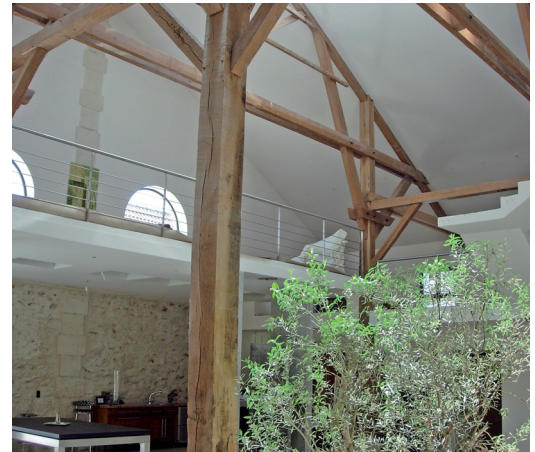
Der Blick vom Erdgeschoss bis unter das zehn Meter hohe Dach zeigt die großzügige Bauweise.
